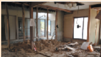
↑築88年の古民家再生の現場
